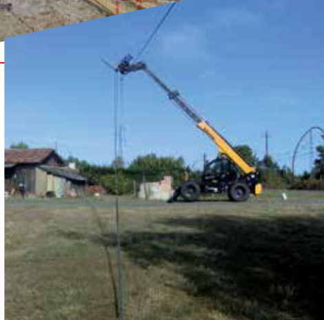
Suppression de la ligne aérienne
